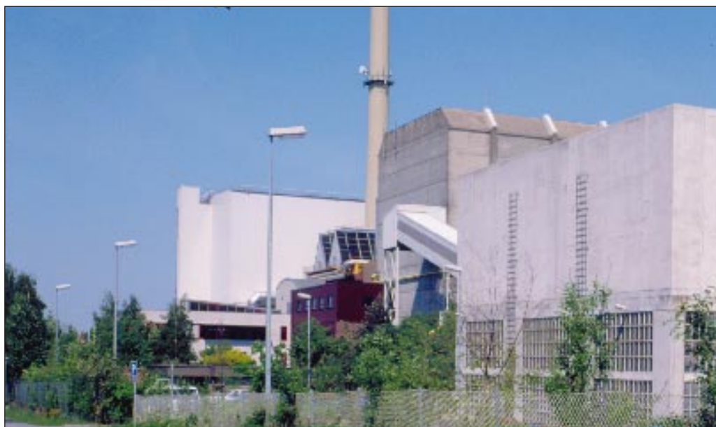
Müllverbrennungsanlage / Waste Incineration Plant
