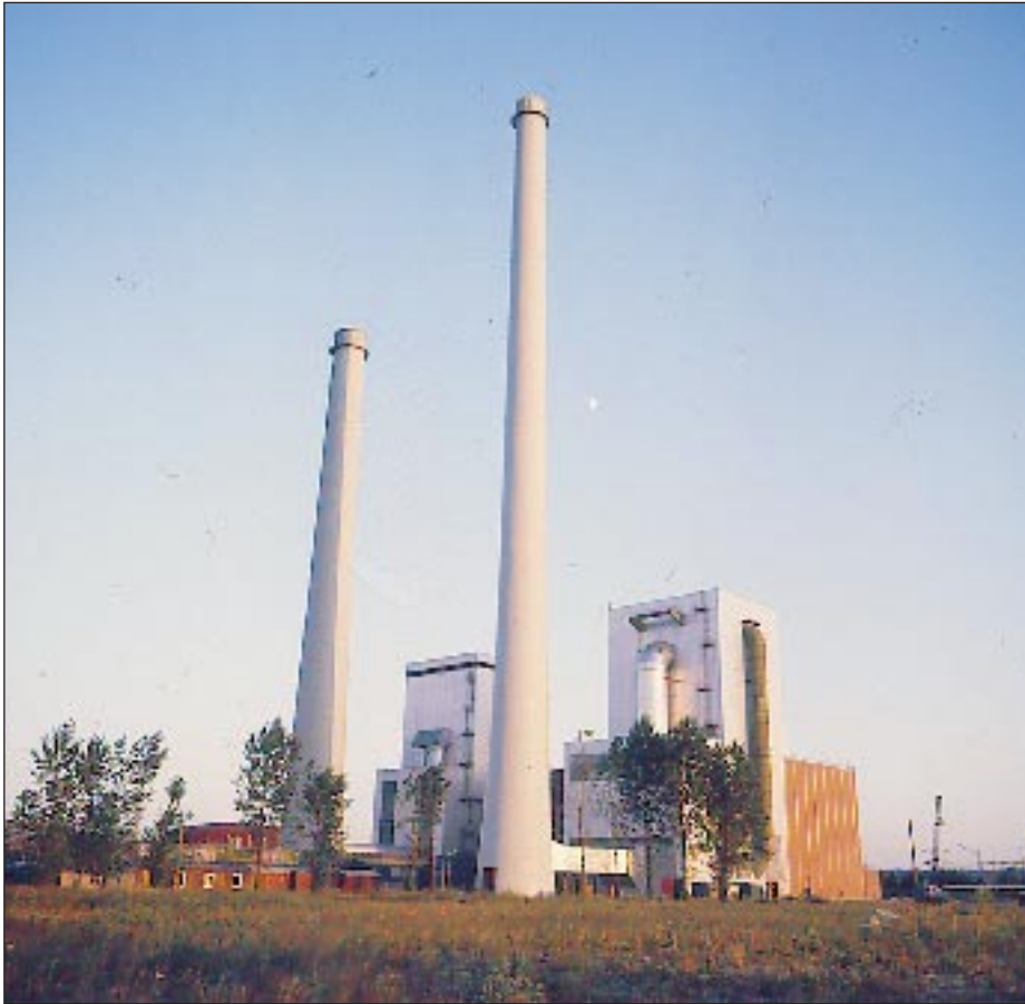
Kraftwerk / Power station
