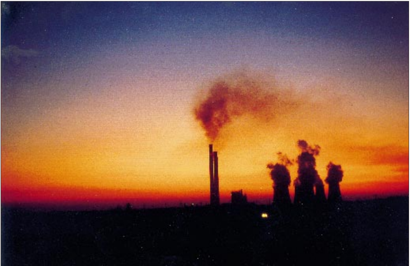
Braunkohlekraftwerk / Coal power station
