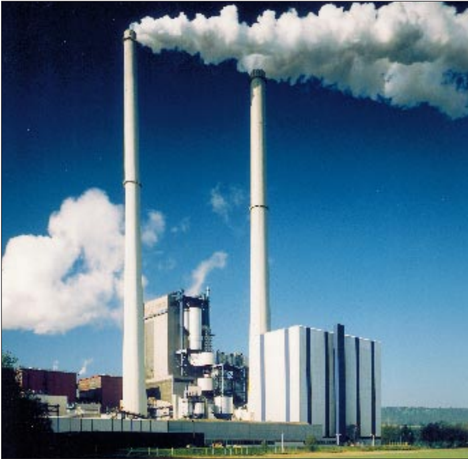
Braunkohlekraftwerk / Coal power station
